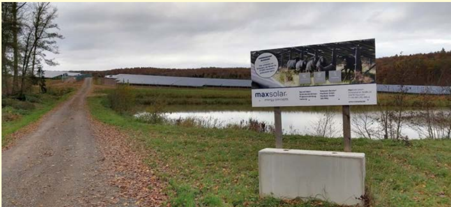
An die Gemeinde Sulzdorf grenzt die gigantische Photovoltaikanlage in Bundorf.
